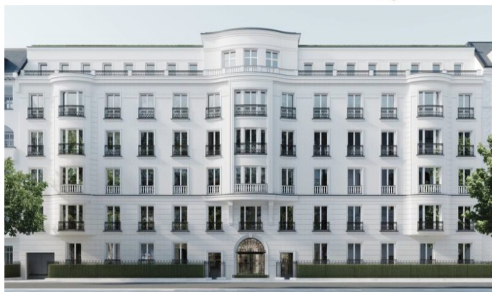
Die Architektur stammt von Sebastian Treese, die Lobby wurde von Bottega Veneta gestaltet: Fassadenansicht der Berliner Eisenbahnstraße 1
